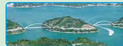
岡村大橋〔橋長:228m〕
